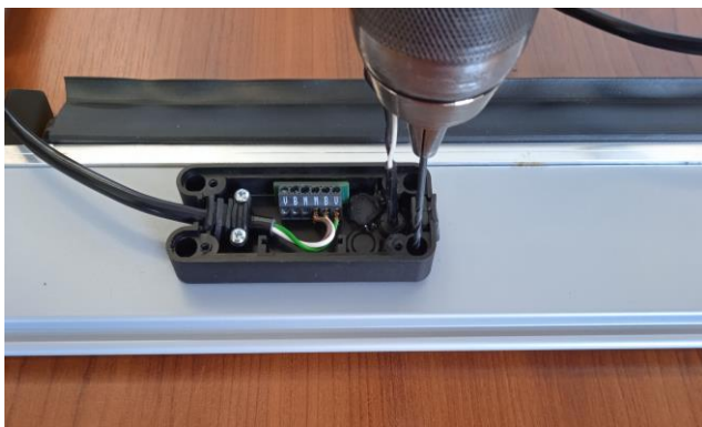
31. W równo ułożonej puszcze nawiercamy otwory wiertłem fi 2,2 a następnie przykręcamy śrubkami które znajdują się w puszcze.
