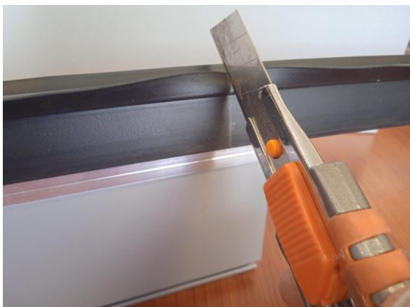
15. W zaznaczonym wcześniej miejscu odcinamy listwę rezystancyjną.
